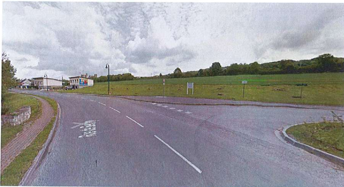
Vue du site depuis la Rue de Berny/RD 193 – Source : Google Maps
