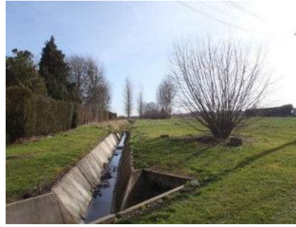
Bassin de lagunage à Sourdon
