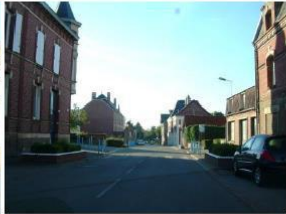
Rue Sadi Carnot (RD 193) : axe de desserte de la vallée vers la Falaise parallèle à la pente du terrain
