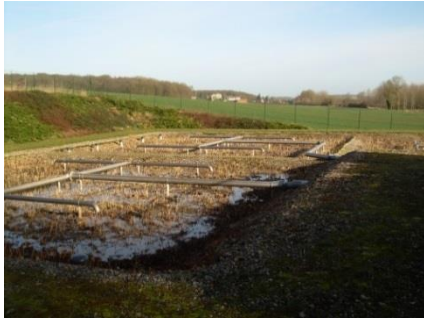
Station d'épuration à Cottenchy
