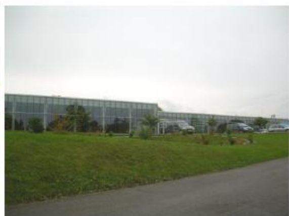
Complexe sportif implanté en fond de vallée
