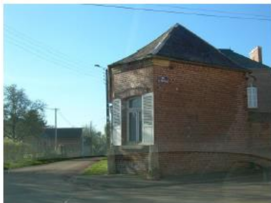
Quiry-le-Sec : Bâtiment à angle coupé qui marque et accompagne le carrefour
